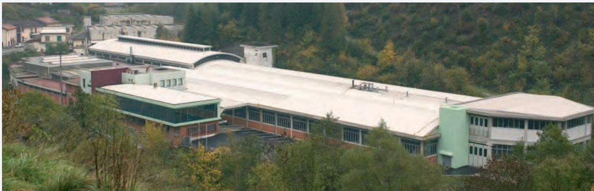
Stabilimento di Brozzo
