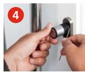
4 Fissare il pomello esterno usando le chiavi brugole in dotazione.
